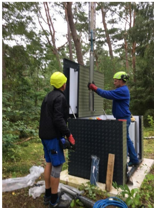
Optagning af pumpe for rensning
